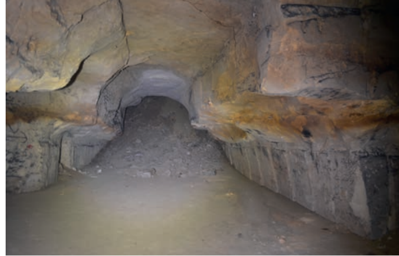
▲ AFBEELDING 12: Meest zuidelijke gang die vermoedelijk ooit de verbinding met de Champignonskuil vormde voordat een instorting hier een einde aan maakte. Merk op dat de onderkant van de gang gemiddeld twee keer zo breed is dan de bovenkant.
