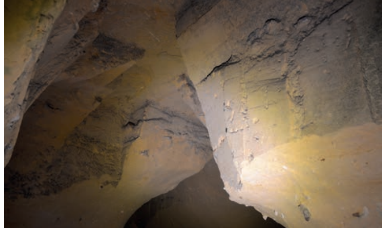
▲ AFBEELDING 43: Een afgeschuinde hoek op de kruising van een pilaar in het bovenste ontginningsniveau met blokvormen.
