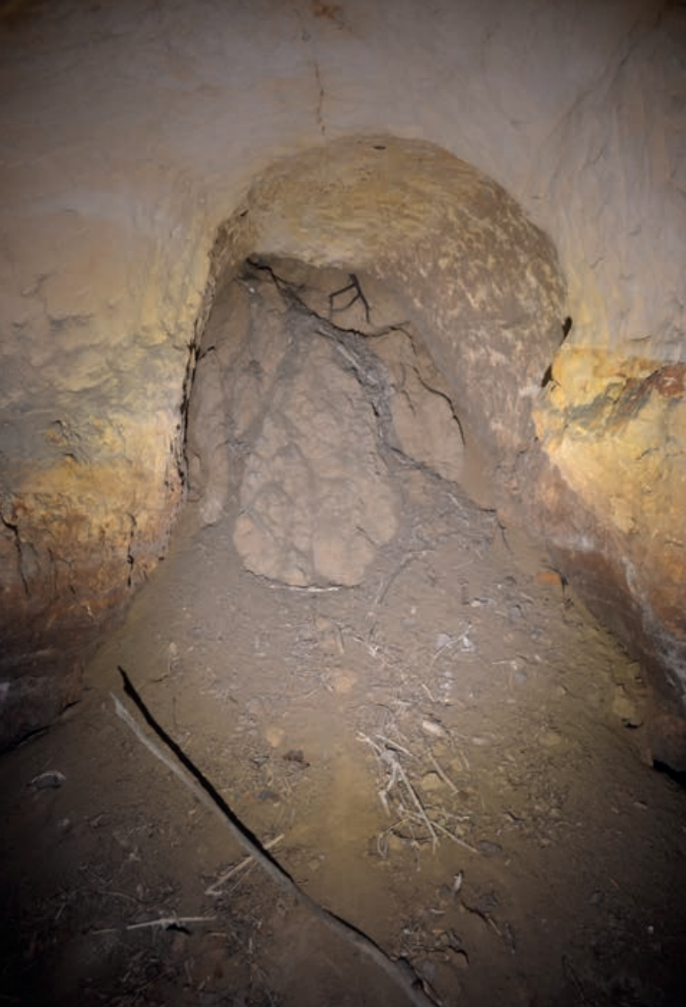
◀ AFBEELDING 58: Een smalle gang versperd door een puinkegel van grond, vermoedelijk een leeggelopen aardpijp.
