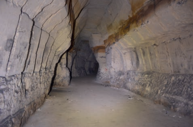
▲ AFBEELDING 11: Een deel van de hoofdgang "Rue de Paris" die een paraboolvorm heeft en waarvan de onderkant gekapt is en voor de winning van mergelpoeder is ontgonnen.
