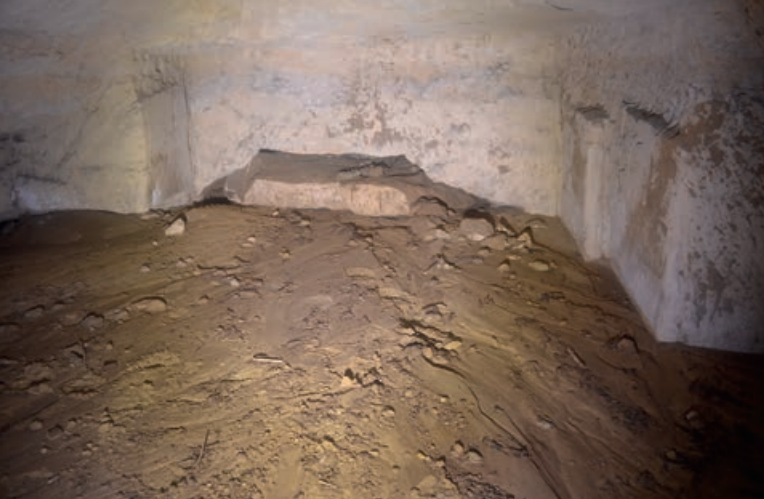
28 ▲ AFBEELDING 29: De bron van verse modderinspoeling in het ingangsgebied, een plafondlaag is doorgebroken en er heeft zich vermoedelijk een instortingskrater of depressie gevormd waarin regenwater zich verzameld en de groeve in stroomt.
