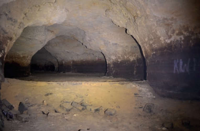
◀ AFBEELDING 56: De fundering of onderkant van een van de muren die gemaakt is met beton blokken.
