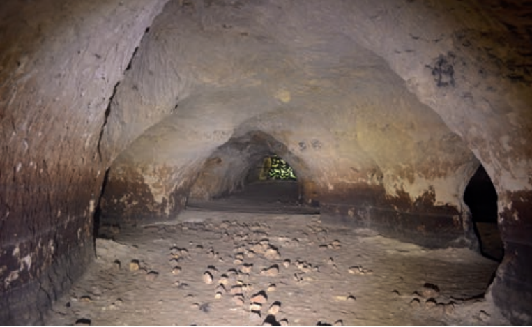
▲ AFBELDING 54: Het typische landschap van deze groeve kijkende richting de ingangspartij. De ontginning heeft plaatsgevonden met een gereedschap met een spitse punt voor de winning van mergelpoeder. Merk de donkere kleur op aan de onderkant van de pilaren van het (grond)water wat hier lang heeft gestaan.
