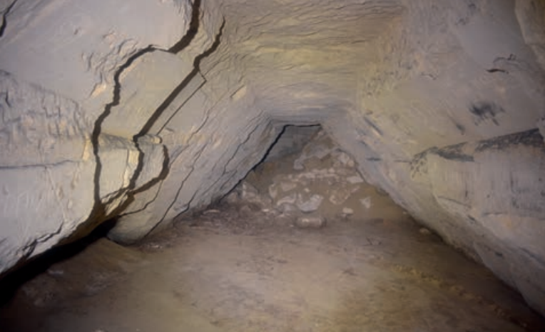
▲ AFBEELDING 20: Een gang met een typische paraboolvorm, zeer waarschijnlijk ter ondersteuning van het plafond.
