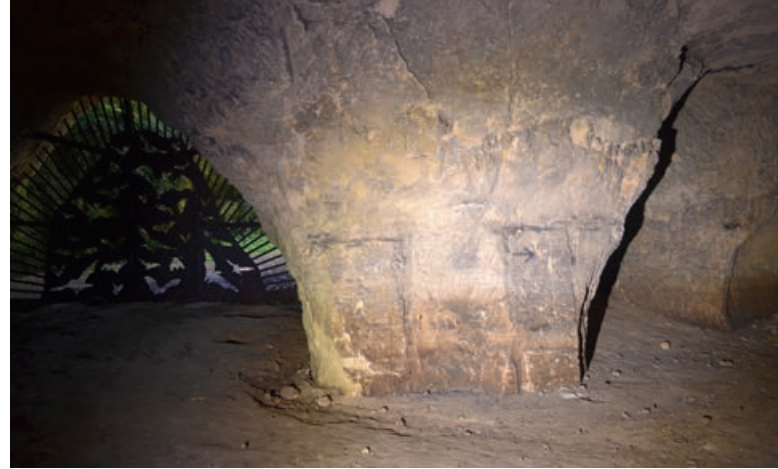
▲ AFBELDING 55: Een van de weinige blokvormen en zaagsporen die erop wijzen dat er vermoedelijk ook pogingen zijn ondernomen voor het winning van blokken.
