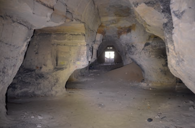
◀ AFBEELDING 13: De onderkant van de pilaren, ontstaan door uitdieping voor mergelpoeder, is duidelijk versmald in het gebied grenzend aan de ingangspartij.
