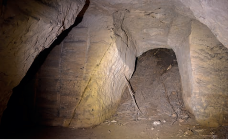
▲ AFBEELDING 45: Een van de ingangen die grotendeels is opgevuld met grond. Merk op dat de gangen een afwisseling van zaagsporen met bloksporen en gekapte wanden vertonen. De duidelijk zichtbare diaklaas (geologische storing) is vermoedelijk de reden dat er gekapt werd omdat de mergel enkel als poeder ontgonnen kon worden omdat de kwaliteit niet voldoende was voor blokken.
