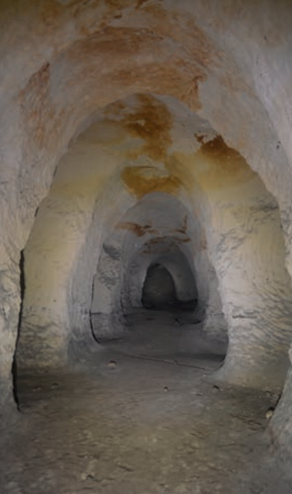
◀ AFBEELDING 32: Typisch landschap in deze groeve, met hoge gekapte gangen voor de winning van mergelpoeder, foto gemaakt vanuit het diepste punt richting de toegang.
