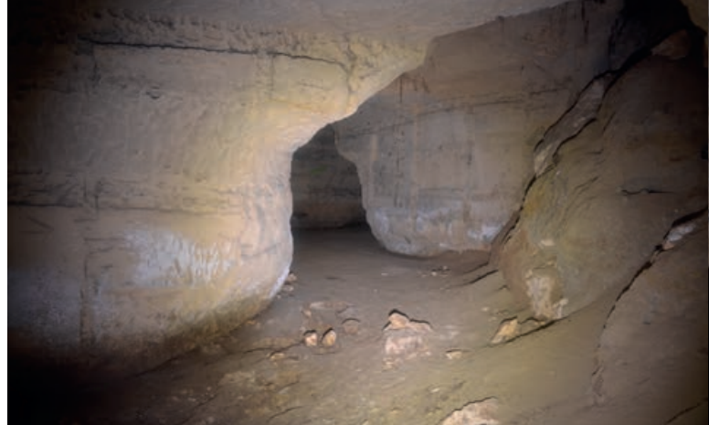
▲ AFBEELDING 26: Gang met weggegraven puinkegel en karrensporen in beide pilaarhoeken.
