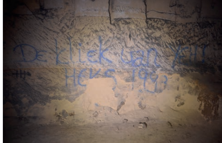
▲ AFBEELDING 18: Moderne graffiti uit 1993 waarvan de onderkant sterk is aangetast door vorstverwerking.
