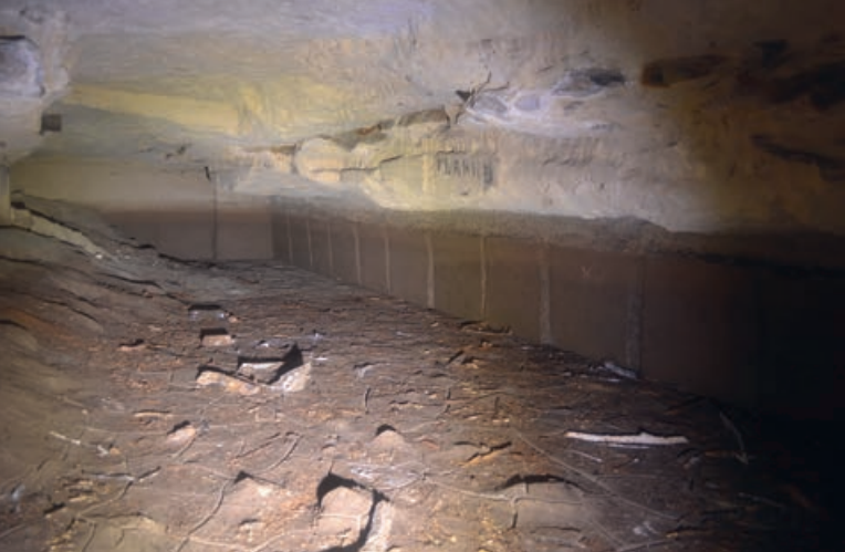
24 ▲ AFBEELDING 22: Roofbouw zichtbaar in de pilaarwand, na de ontginning van de gang is er een volledige blok-dikte opnieuw uit de pilaar ontgonnen op een iets lager niveau waardoor ook de oude ontginningssporen nog zichtbaar zijn.
