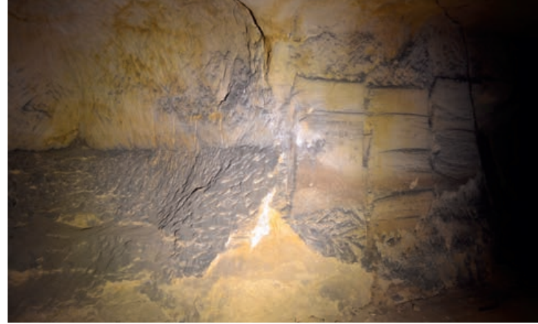
▲ AFBEELDING 46: Overgang van een gekapte gang (links) naar blokvormen, merk de verticale zaagsporen (lijnen) op die mogelijk erop wijzen dat de mergel werd ingezaagd voordat deze ontgonnen werd voor mergelpoeder.
