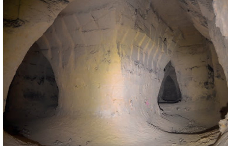
▲ AFBELDING 39: Een pilaar 40 m dieper in de groeve waar de gang breedte onderaan minder extreem dan vooraan is.
