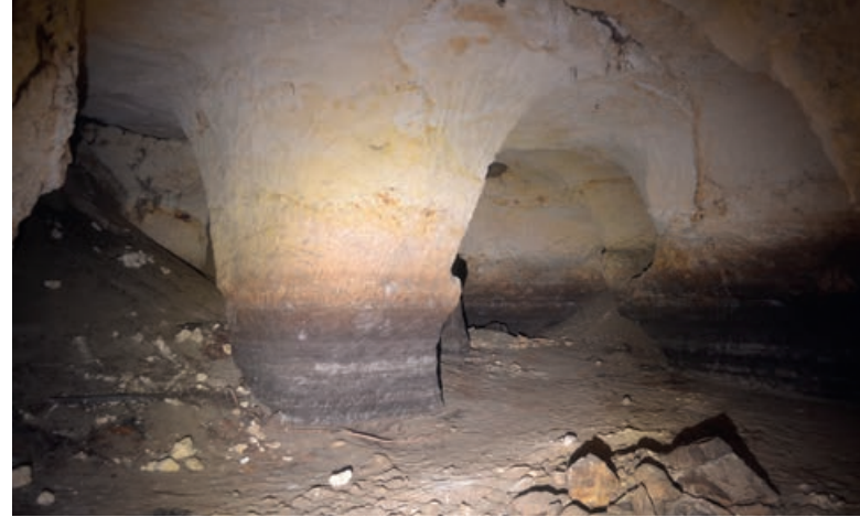
▲ AFBEELDING 60: Het ondergrondse gangenstelsel kijkende in westelijke richting naar een puinkegel van grond en afval. Merk de diaklaas in het plafond op en de verschillende standen van het (grond)water.
