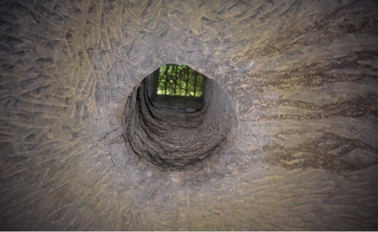
▲ AFBEELDING 2A: Gereedschap sporen met een spitse punt in het plafond van de groeve Hinnisdael VII, de schacht is van latere datum.
